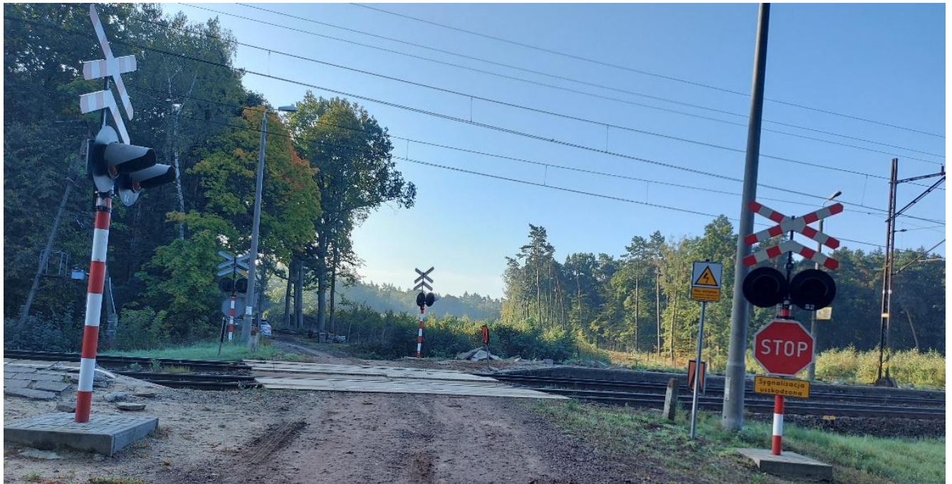
Fot. 2 Widok ogólny przejazdu kolejowego – od strony dojazdów do jeziora.
